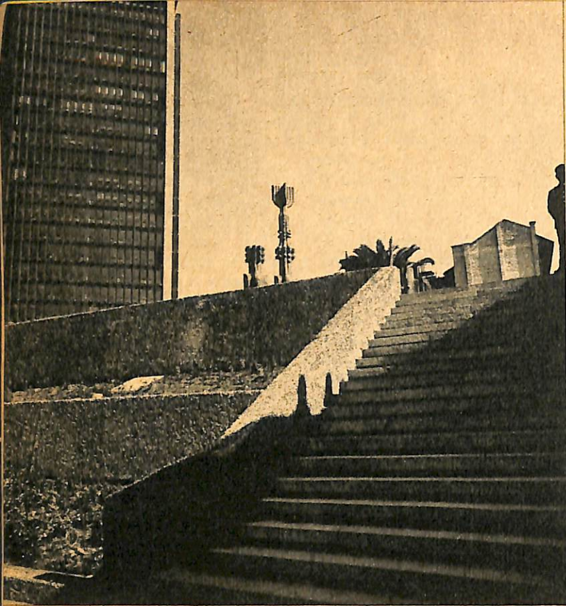
Las escalinatas hacia el exterior conducen a la plazoleta y permiten el acceso a los niveles creados en este espacio. En sí mismas son elementos funcionales a los que se agrega una función ornamental: permiten espacios visuales y perspectivas para el conjunto de construcciones, jardines y esculturas
