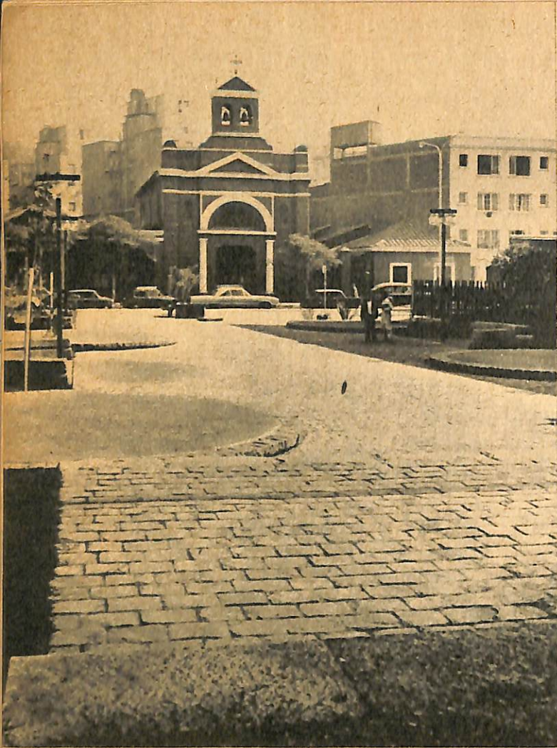
Mediante desplazamientos espaciales a partir de la planificación Unidad, el barrio Villavicencio-Victorino Lastarria, que es desde hace mucho tiempo uno de los sitios pintorescos del área central de nuestra ciudad, ha quedado comunicado. La nueva edificación funcional se enlaza sin rechazos de orden estético ni urbanística, con la arquitectura de este barrio, enriqueciéndolo y descubriéndole perspectivas antes ocultas. El edificio ha recuperado como zona de circulación el "centro de manzana" de esta área.
